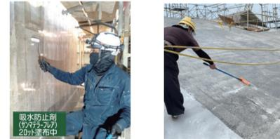
サンマテラーフレア塗布後、主成分のシラン・シロキサンは毛細管空隙を伝わりより奥に含浸します。コンクリート中の水分や水酸基 (-OH) と反応しRSiO<sub>2</sub>の遮水層が形成されて毛細管空隙を充填し緻密化します。またこの遮水層は、網目構造になっており表面には有機基が外側に向かって配置されるため水を弾く撥水性が得られます。水は弾きますが空気や水蒸気は透過するためコンクリートの呼吸性を阻害しません。塩化物イオンや水などをブロックして鉄筋腐食膨張やASRの膨張を間接的に低減します。
