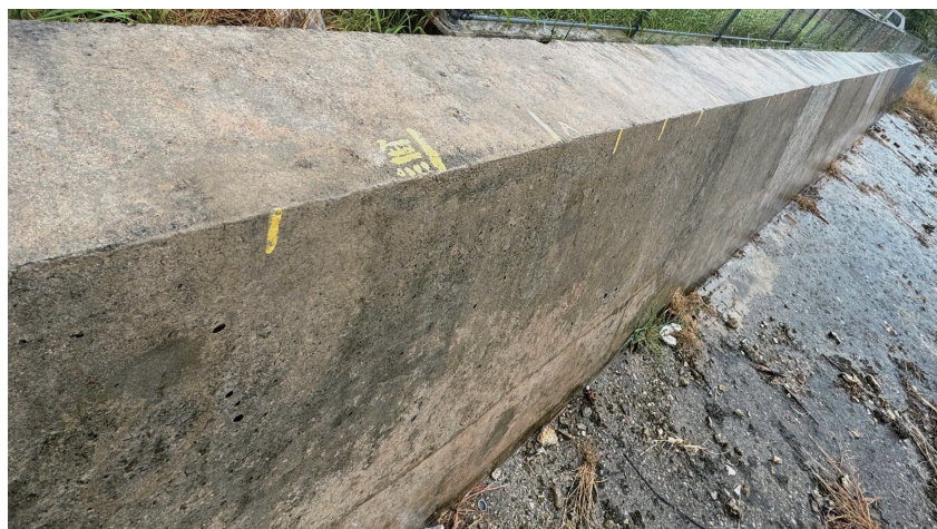
塩害地の築 50 年を越すコンクリート護岸 におけるシュミットハンマー試験
