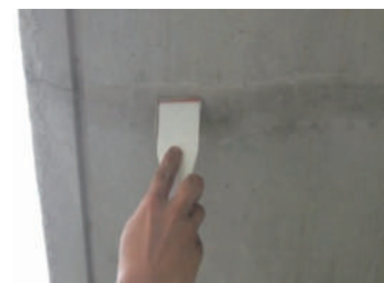
超微粒子セメントを擦る切 乾燥後、サンドペーパーで 余分ネタを除去
