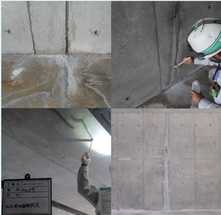
現場打設のボックスカルバートの漏水止水
