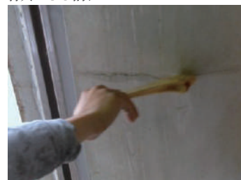
ひび割れ部にサンマテラーアクア 2 回塗布
