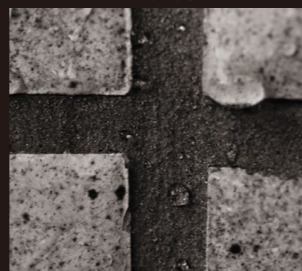
目地部を遮水して 外壁タイルの浮き予防
