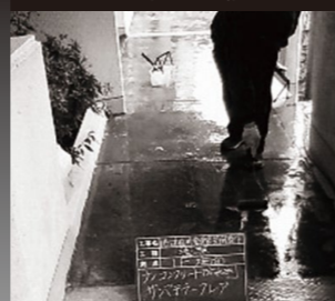
集合住宅の床に施工 白華抑制、漏水対策
