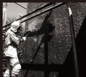
ハツリ仕上のかぶり部分 を遮水し鉄筋防錆
