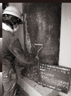
経年コンクリートの維持保存に
